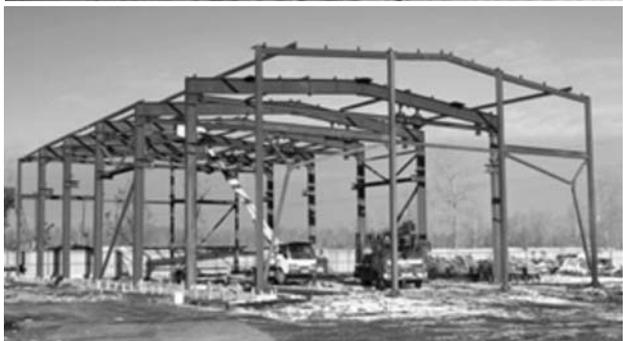
Рисунок 2 - Пример применения стальных балок покрытий ОПЗ на фланцевых соединениях [4]
